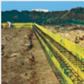
Bednění osazené „volně“
