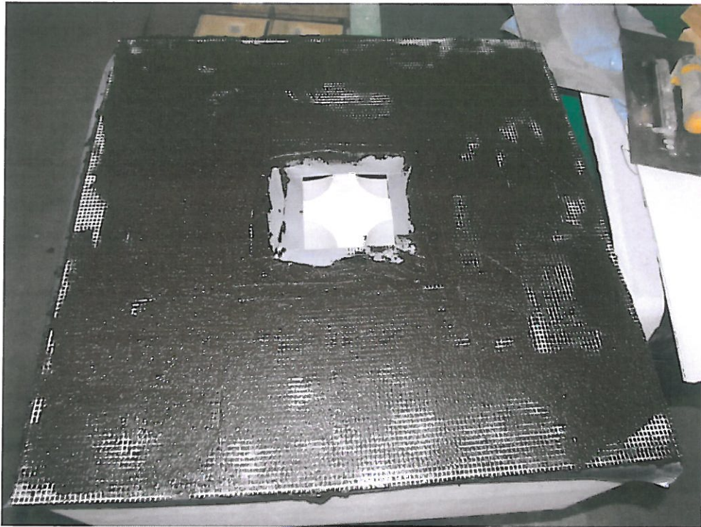
Bild 5: Auf der Prüfkörperoberfläche aufgetragenen kunststoffmodifizierte Bitumendickbeschichtung mit eingelegtem Glasseidengewebe
