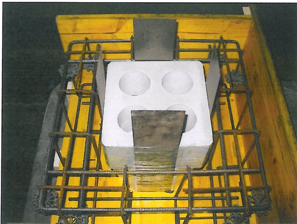
Bild 2: Einbau der Mehrspartenwanddurchführung mit seitlich angebrachten 0,5 mm dicken Blechen zur Nachstellung von Schwindfugen
