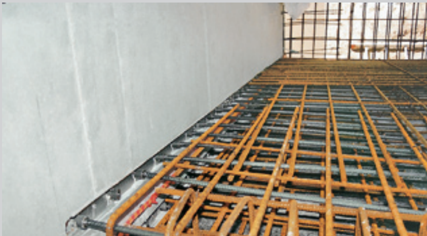
CA-prut s trubkovou maticí vč. chrániče závitu
