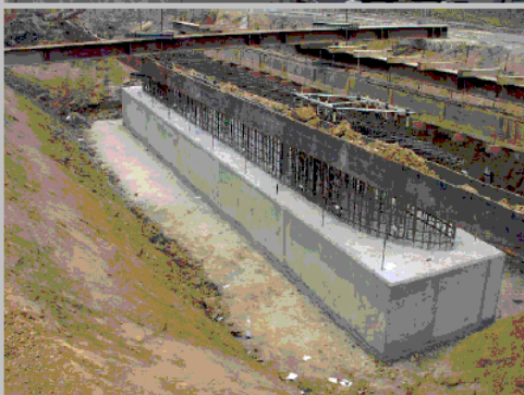
trám na pilotách u středního pilíře
