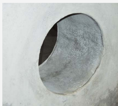
Hotový, přímo při betonáži vytvořený kruhový prostup
