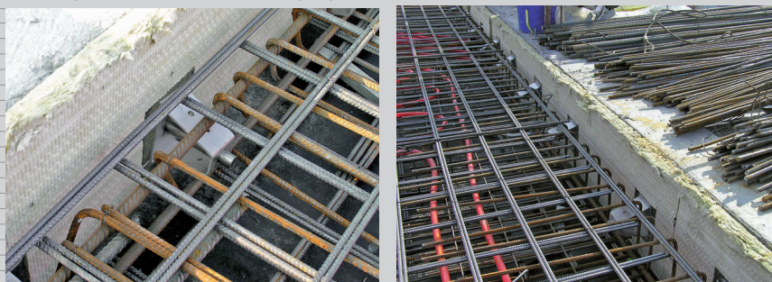
Dilatační spára s osazenou trnovou částí a protipožární manžetou
