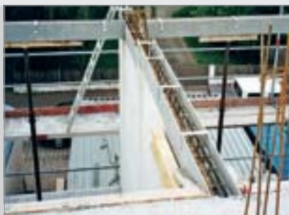
■ Žlabové bednění překlady z dřevotřískových desek spojených cementem významně ulehčuje bednění a betonáž obvodových věnců na stavbě.
