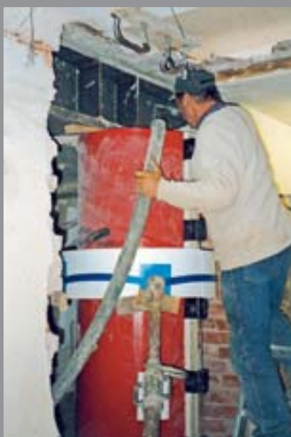
Betonáž do opláštění stávajícího sloupu při zachovaném průvzlaku
