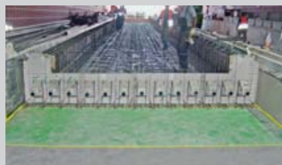
Kompletní bednění ze Stremaformu s již z výroby zabudovaným systémem Egcodorn. Slouží jako bednění a vyztužení dilatační spáry.
