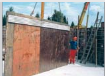
■ Ztracené bednění lemů z vláknobetonu připevněné na bednění před jeho montáží
