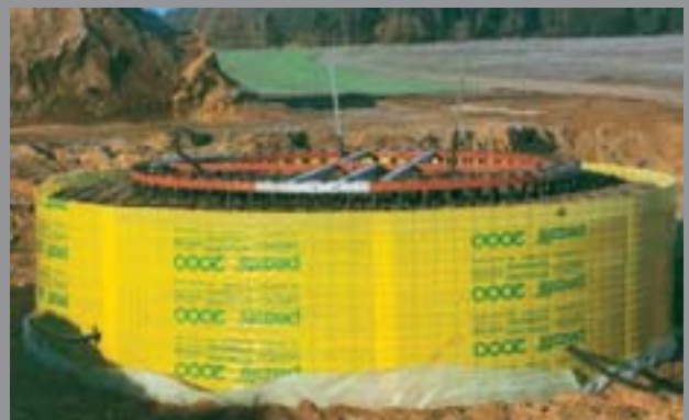
Bednění základů – vyjímatelné, vícekrát použitelné
