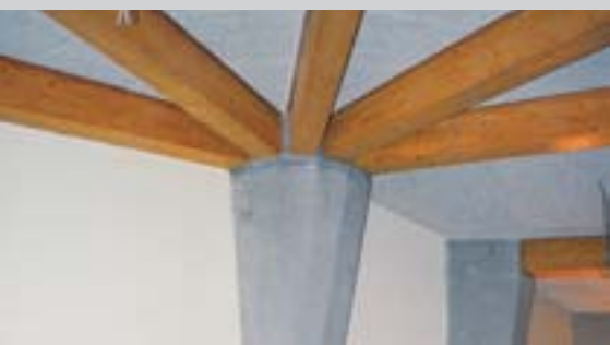
rozšíření sloupu pro osazení dřevěné konstrukce
