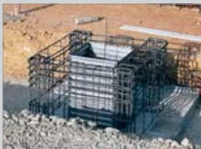
■ Ztracené bednění kalichů s vynikajícím přenosem smykových sil
