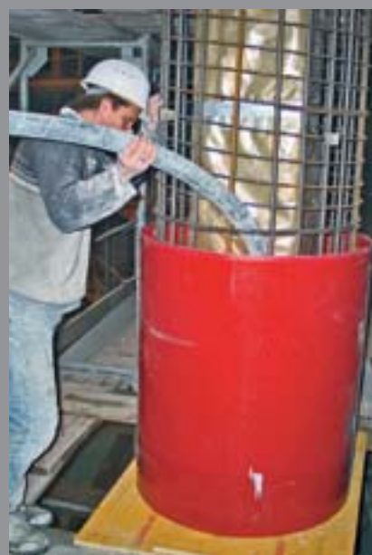
Bednicí trubka na betonové opláštění stávajícího sloupu. Opláštění se vybetonuje ve dvou záběrech.
