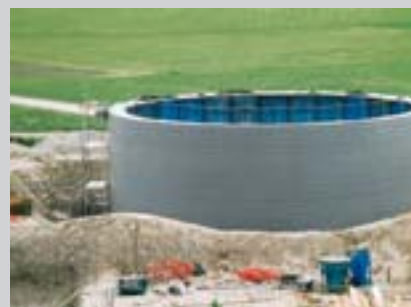
Ocelové bednění s napnutým Zemdrain®em
