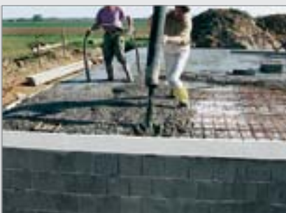
■ DIS – izolační bednění lemů stropních desek
