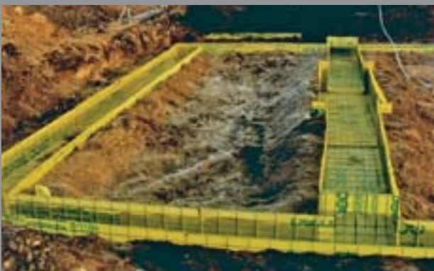
Bednění základů ve tvaru U jako ztracené bednění z prvků předem naohýbaných již z výroby
