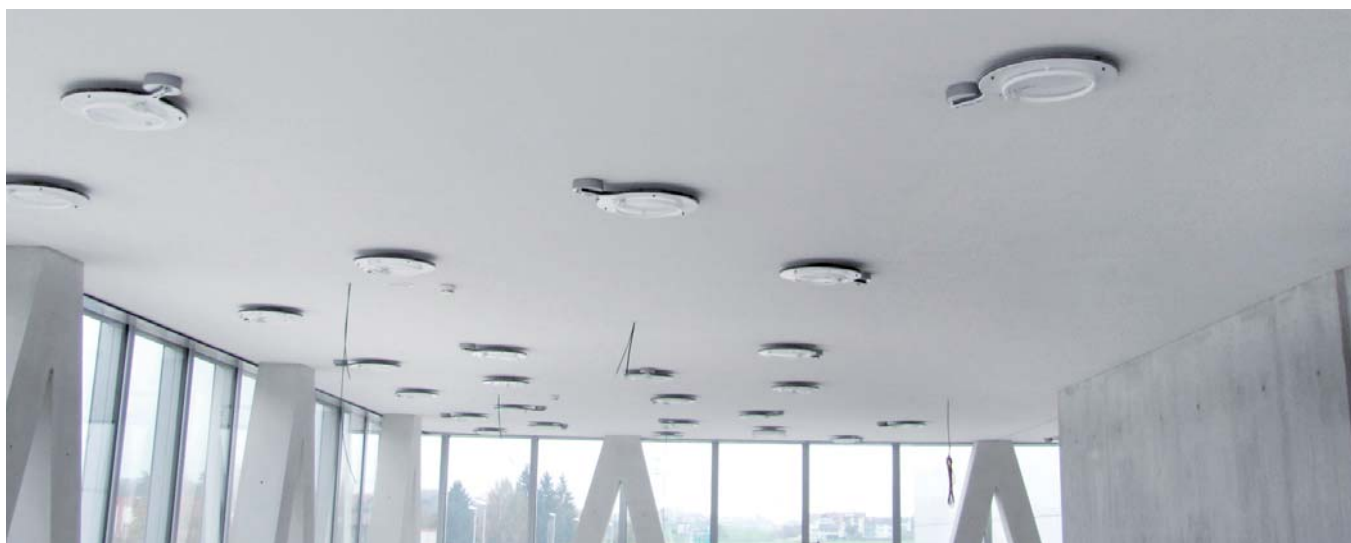
Vzhled povrchu stropu s akustickou omítkou
