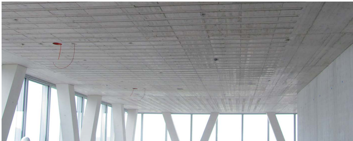
Pásky akustických absorbérů ve stropu (hrubá stavba)
