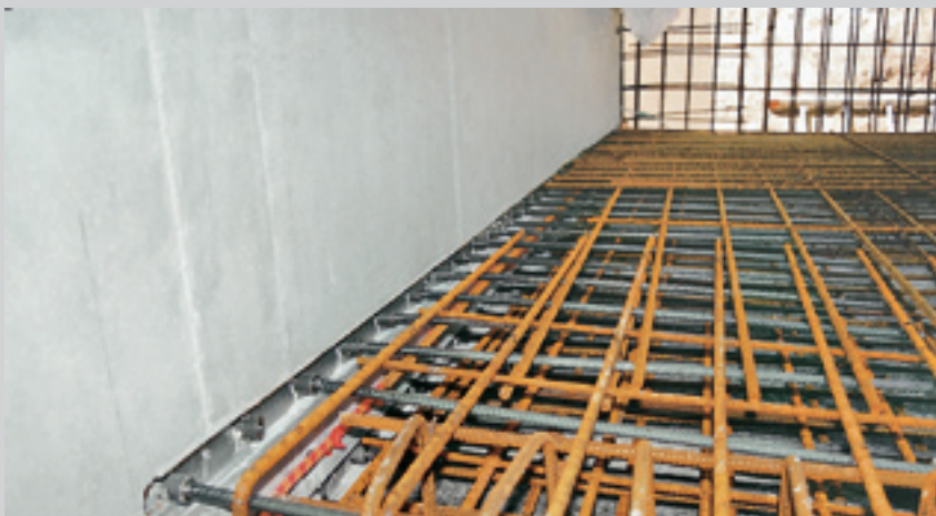
CA-prut s trubkovou maticí vč. chrániče závitu
