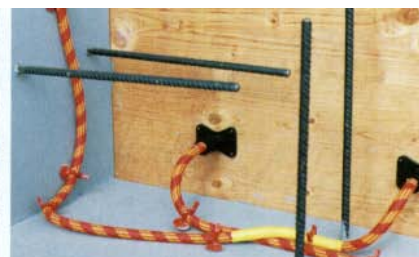
6. Kompletní injektážní smyčka po skončení montáže
