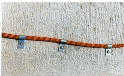
5. Uložení hadičky (odvinitím z role) a její připevnění v pracovní spáře. Připevnění 2. koncovky (viz 1. až 4.)
