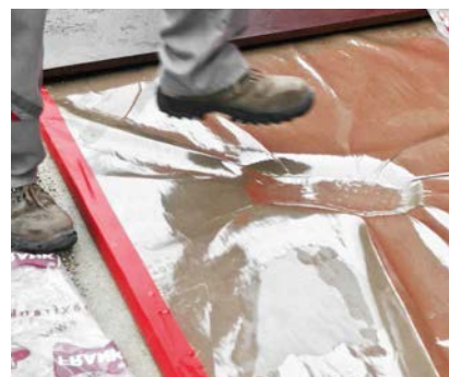
po 24 hodinách je veškerá únosnost bednění Egcovoid® zlikvidována
