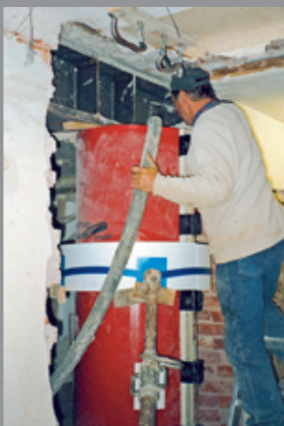
Betonáž do opláštění stávajícího sloupu při zachovaném průvlaku
