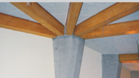
rozšíření sloupu pro osazení dřevěné konstrukce
