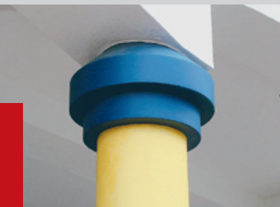
nahoře: písmena v parku dole: optický efekt hlavice sloupu s kruhovým průřezem
