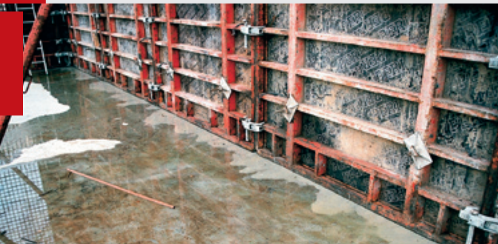
Zemdrain® odvádí nadbytečnou vodu a ta pak uniká pod bedněním ven.
