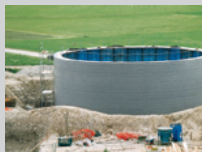
Ocelové bednění s napnutým Zemdrain®em
