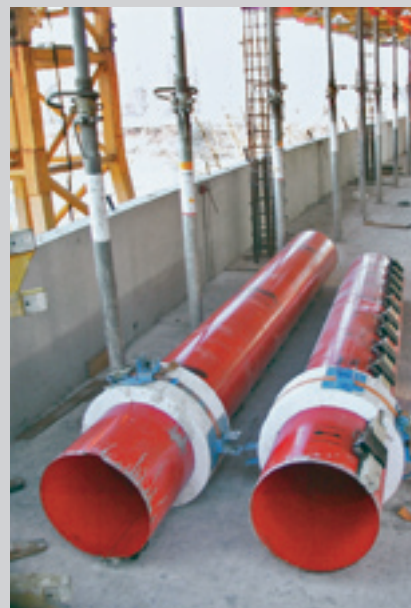
Bednění připravená pro další použití s již namontovanými vyrovnávacími prstenci a napínacími popruhy.
