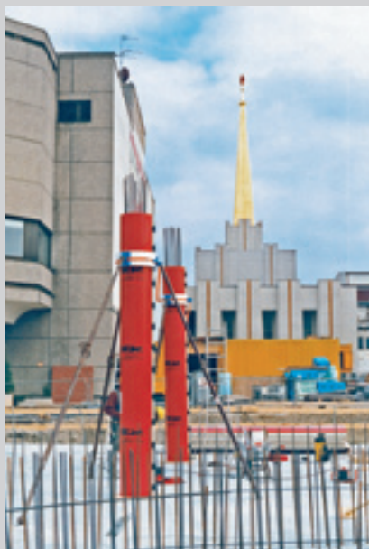
Svislé vyrovnání bednění Tubbox Multi pomocí vzpěr připevněných napínacím popruhem na vyrovnávací prsteneček.
