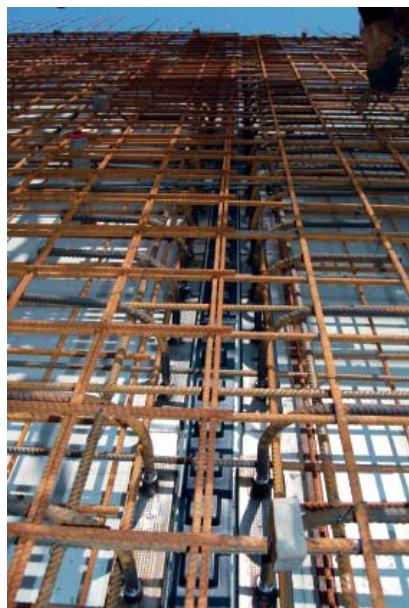
Bewehrungslage im 1. BA: Befestigung der WCA-Muffenstäbe mit der örtlichen Bewehrung
