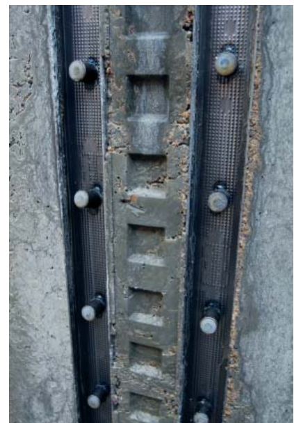
Betonierergebnis: Lage der Coupler-Muffen in der Verzahnungsfuge
