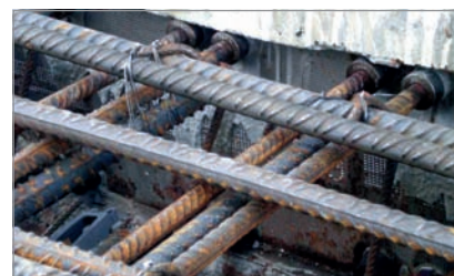
Přesná poloha napojované výztuže ve 2. betonovaném záběru díky jednoduchému osazení závitových prutů Coupler v zazubené spáře.
