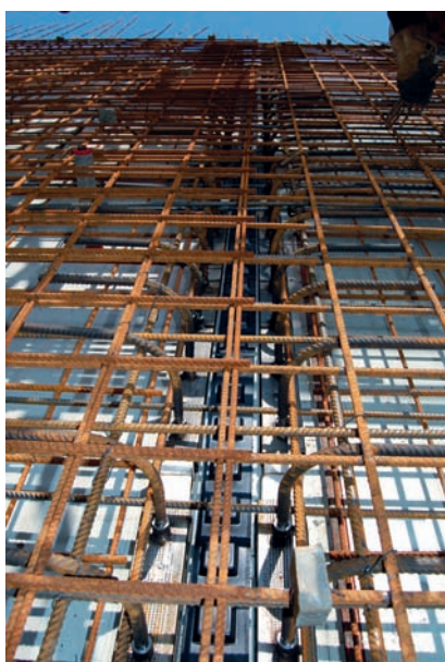
Výztuž v 1. záběru: Připevnění prutů s trubkovou maticí (WCA) k okolní výztuži
