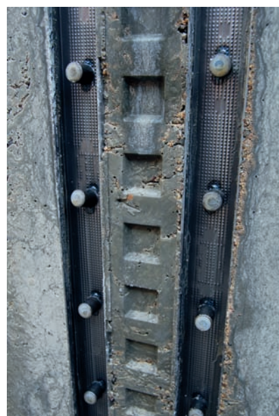
Výsledek po betonáži: Umístění trubkových matic v zabudované spáře
